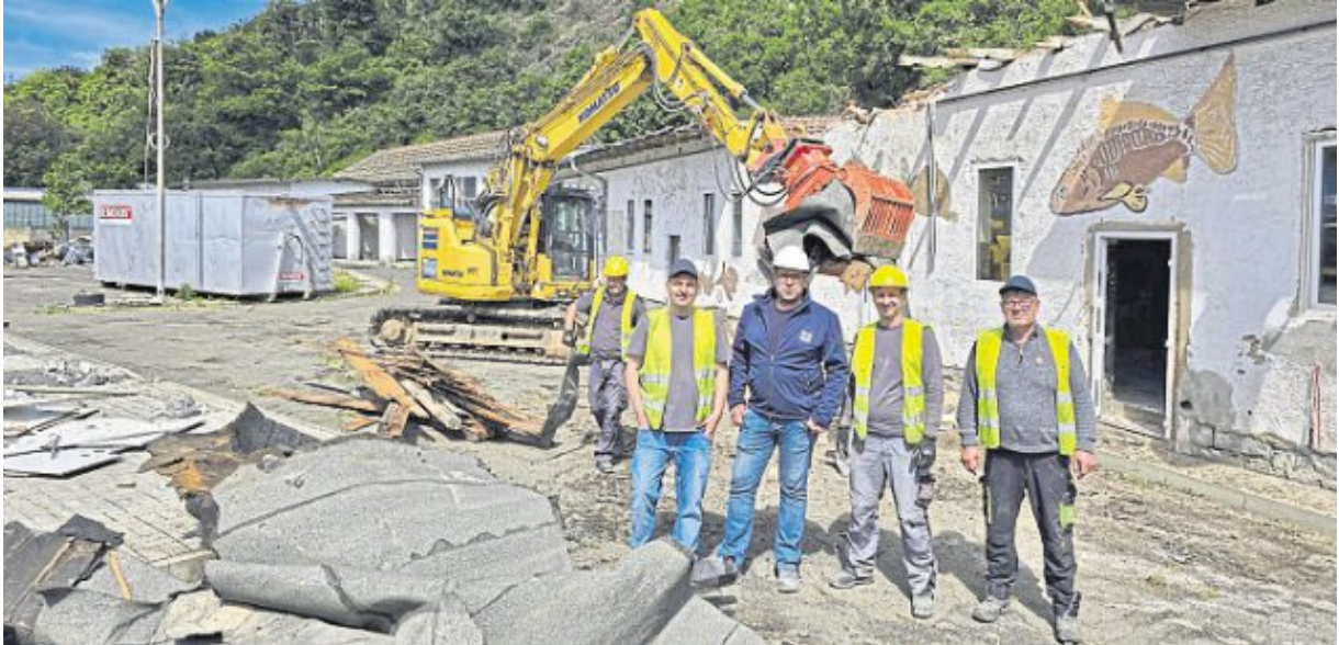
Karen Aghabekyan (Zweiter von links), Geschäftsführer der Firma A.K.A., und Michael Kohl (Dritter von links), Betriebsleiter des Kirner Steinbruchs, freuen sich gemeinsam über den reibungslosen Baufortschritt beim Abriss des Kirner Tierheims.
